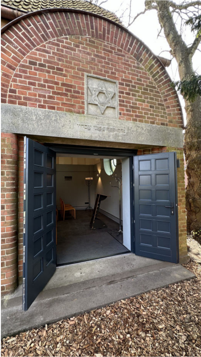
Die Eingangstür zur sanierten Trauerhalle
